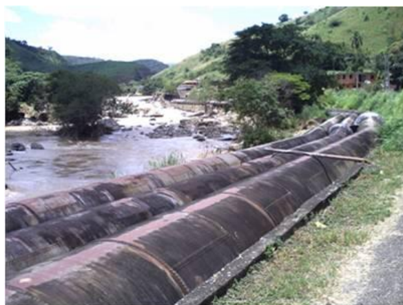
Área a jusante da barragem, detalhe da tubulação que conduz a água até a casa de força.
